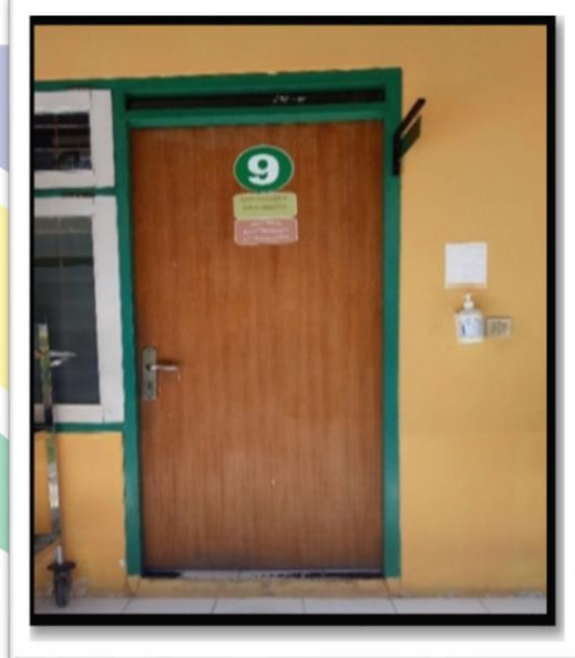
Gambar 3.1 Pintu Utama Ruangan Mikrobiologi di UPTD Laboratorium Kesehatan Provinsi Kalimantan Timur.
