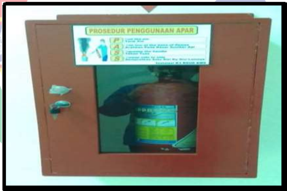
Gambar 4. Dokumentasi APAR Jenis Powder di Laboratorium Patologi Anatomi RSUD Abdul Wahab Sjahranie Samarinda
