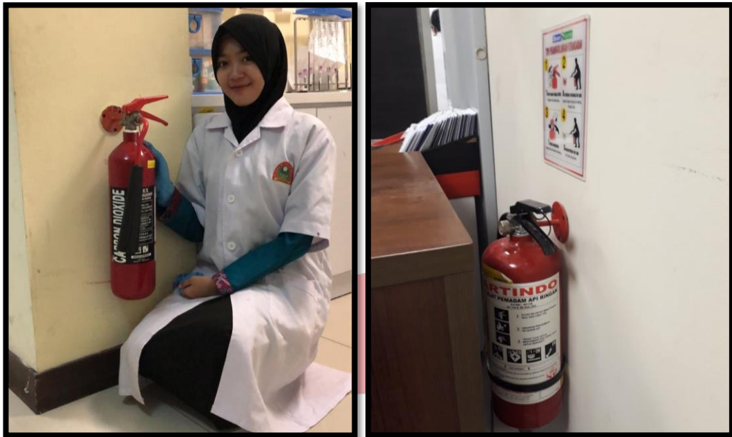
Gambar 1. Alat Pemadam Api Ringan (APAR). Berbahan CO 2 untuk kebakaran kelas B dan C (kiri). Dan APAR berbahan Foam untuk kebakaran kelas A (kanan).
