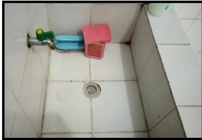
Gambar 4. Wastafel Ruangan Mikrobiologi
