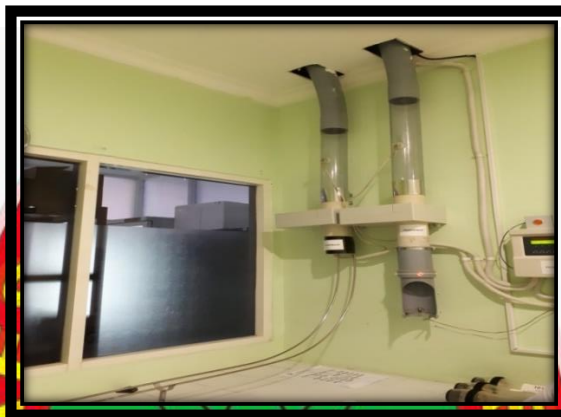
Gambar 26. Aerocom untuk Penemimaan sampel dan Pengiriman Hasil berbasis teknologi yang modern sehingga memerlukan waktu yang singkat untuk menerima sampel dan mengirimkan hasil laboratorium
