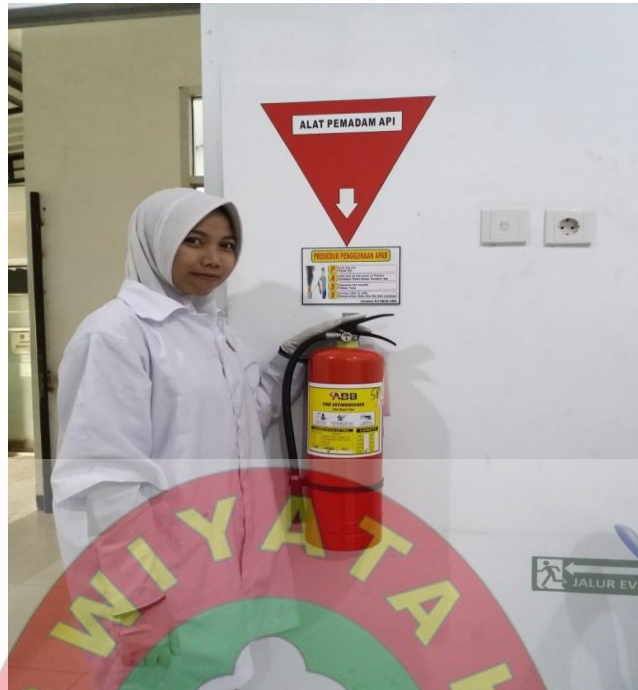
Gambar 3. Alat Pemadam Api Ringan (APAR Water/air). memadamkan api yang dikarenakan oleh bahan-bahan padat non-logam seperti kertas, kain, karet, plastik dan lain sebagainya (kebakaran kelas A).
