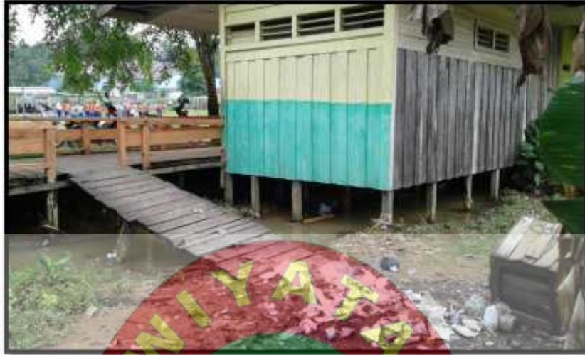
Gambar 1. Tidak Tersedianya Sarana Pembuangan Akhir Sampah
