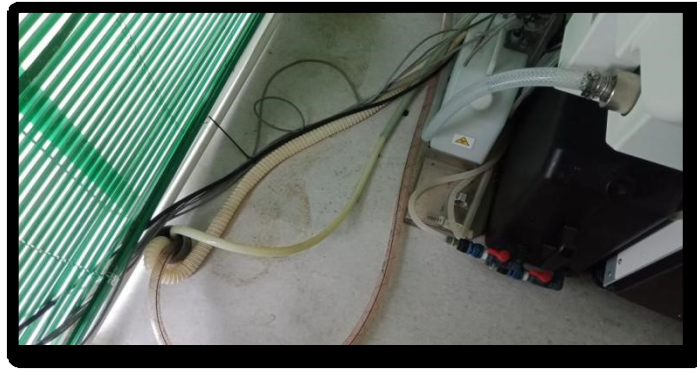
Gambar 18 : Saluran pembuangan limbah cair
